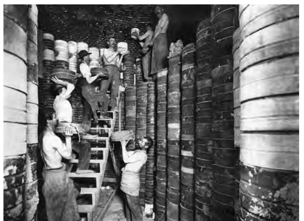
Intérieur d'un four de cuisson
