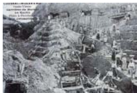
Photo 8 : Ancienne carrière de kaolin, photographie, XIX e siècle.
